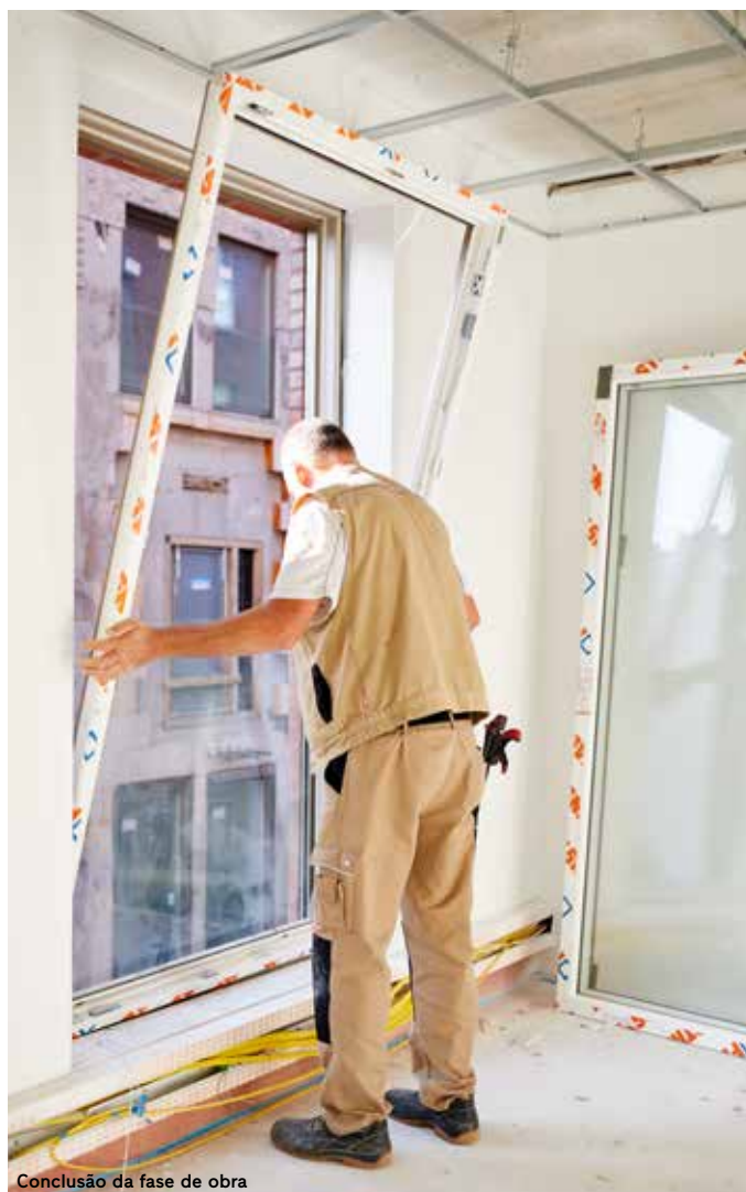
Conclusão da fase de obra
