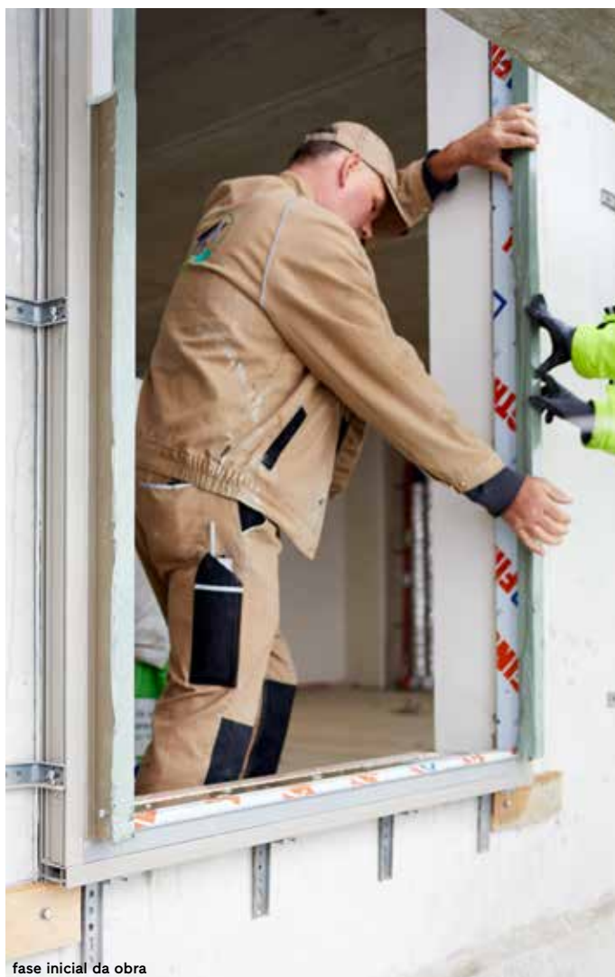
fase inicial da obra
